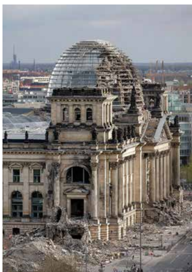
Berliner Bundestagsgebäude als Ruine
