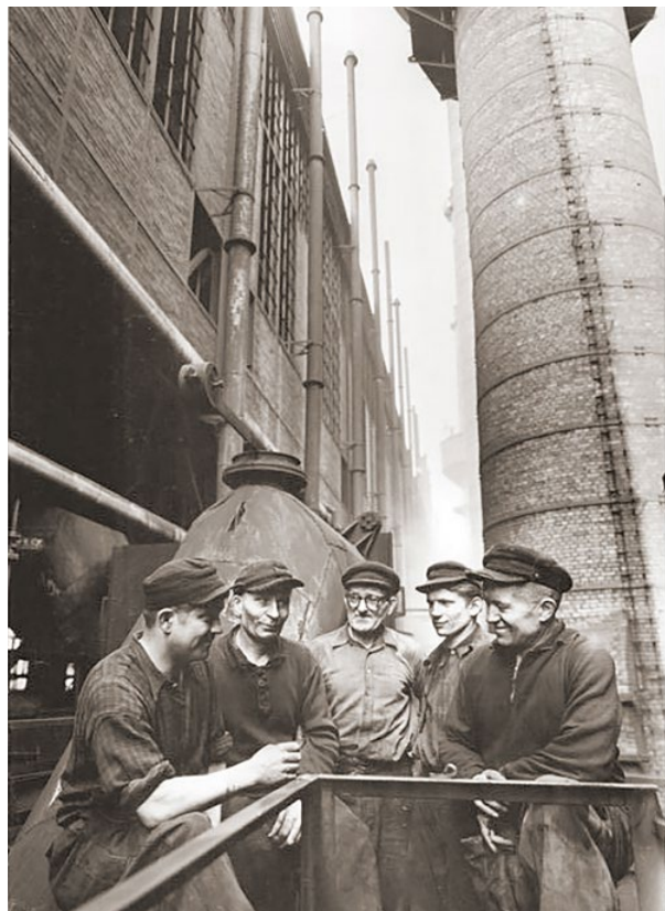
Stahlarbeiter in der BRD, 1959
